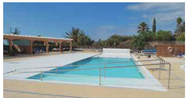
Cubierta con enrollador empalmado
