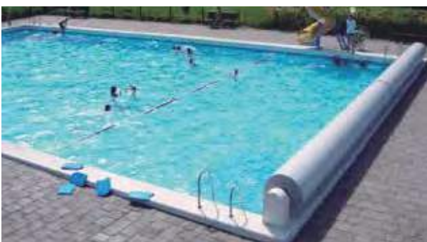
Cubierta con enrollador fijo
